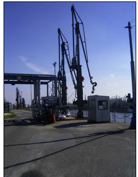
Schiffsverladeanlage
