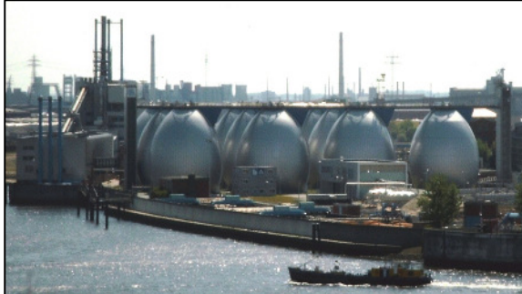
Klärwerk, Faulbehälter
