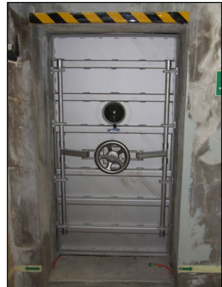
Hochwasserschutztür Abwasserpumpwerk
